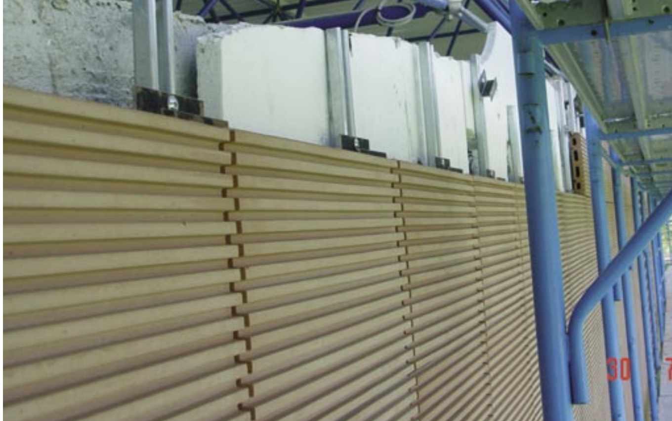
Dettaglio costruttivo della parete ventilata in cotto; pianta della palestra e del corpo spogliatoi Constructive detail of the ventilated brick wall; plan of the gym and dressing room
