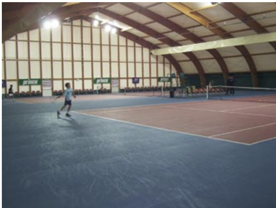
Impianto per il tennis indoor in legno lamellare; sotto: palestra per la ginnastica Indoor tennis facilities covered with lamellar wood; below: gym
