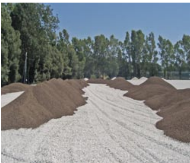
Realizzazione del doppio strato drenante Achievement of the double draining layer
